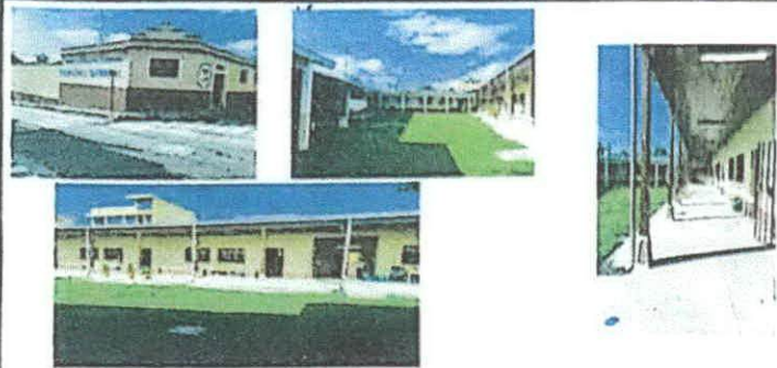
Foto1: Pintura en muros exteriores e interiores y pintura en techo de madera
