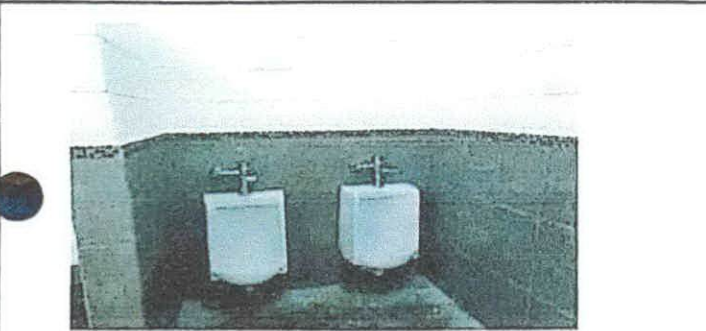
Foto 3: Sustitución de mingitorios
