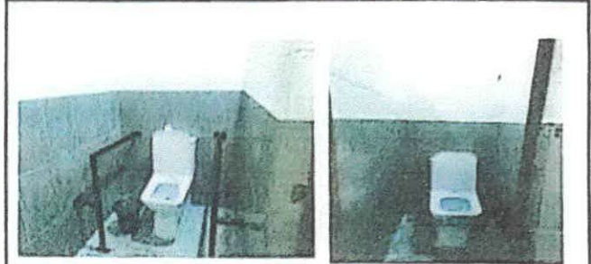
Foto 2: Sustitución de Inodoros
